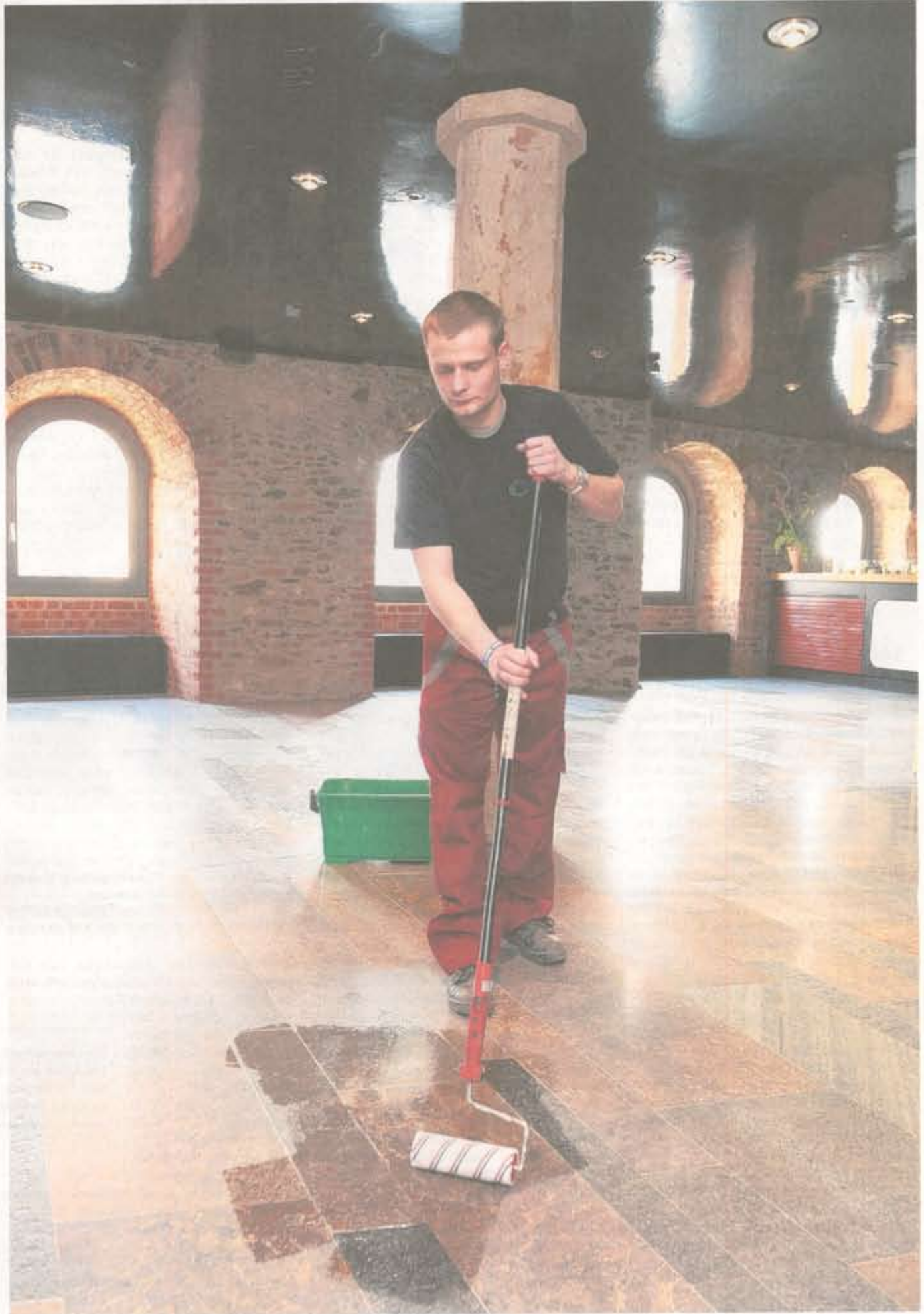
Fußbodensanierer Norman Köhler demonstriert das Verfahren im Schloß Großenhain. Die Beschichtung wird nach der Bodenreinigung einfach mit einer Rolle aufgetragen.
